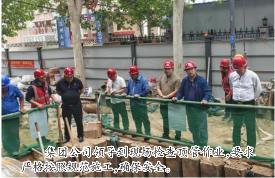
集团公司领导到现场检查顶管作业,要求严格按照规范施工,确保安全。
