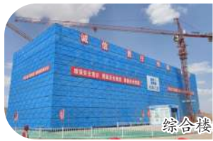
综合楼施工前后
