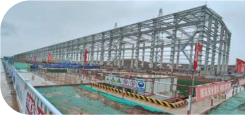
750kvGIS室施工前后
