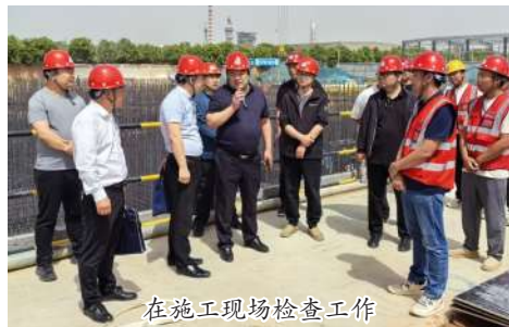
在施工现场检查工作
